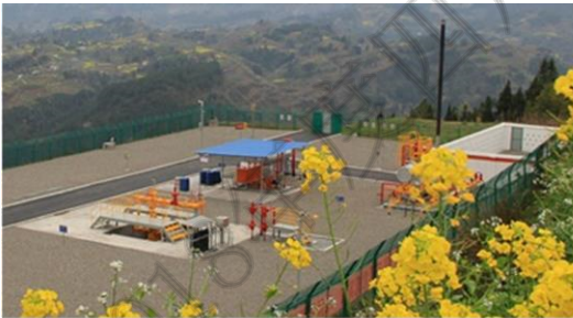
黄龙 009-H1 井高含硫地面工艺撬装化设备
